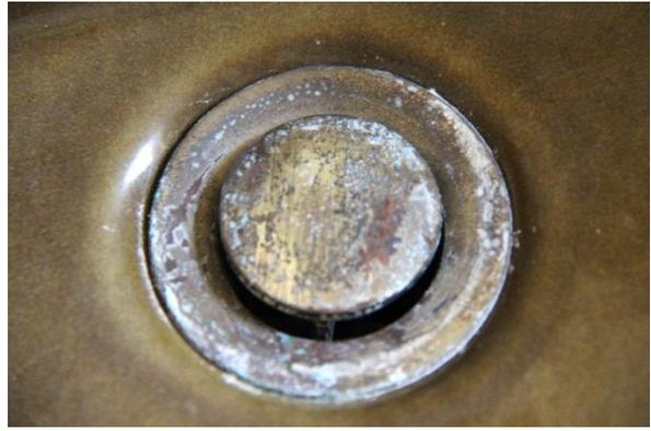
Die Sanitärinstallationen sind zum Teil in Bronze oder Messing „antik“ ausgeführt und so korrodiert, dass sie ausgewechselt werden müssen.
