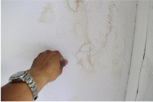
ein leicht hohles Klopfecho deutet auf ein an dieser Stelle vermindertes Isolationsvolumen hin, verursacht durch die Materialsetzung aufgrund der Feuchteinfiltration.
